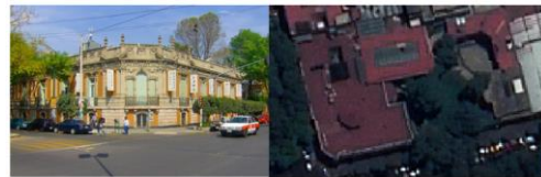
Figura 1. Vista en perspectiva y en planta (desde un sensor en órbita) del museo Casa Lamm, en la colonia Roma Norte, Cd. de México.
